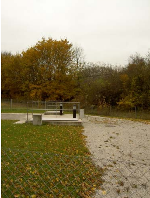
Zugang und Einstieg Regenrückhaltebecken
